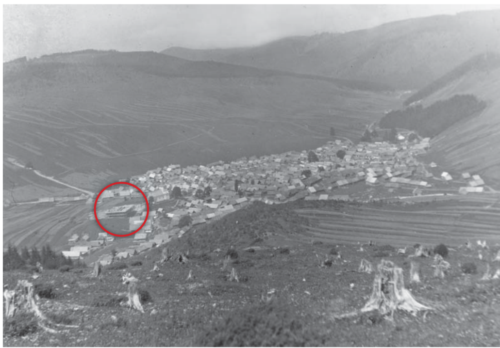
Začiatok výstavby školy v r. 1932
